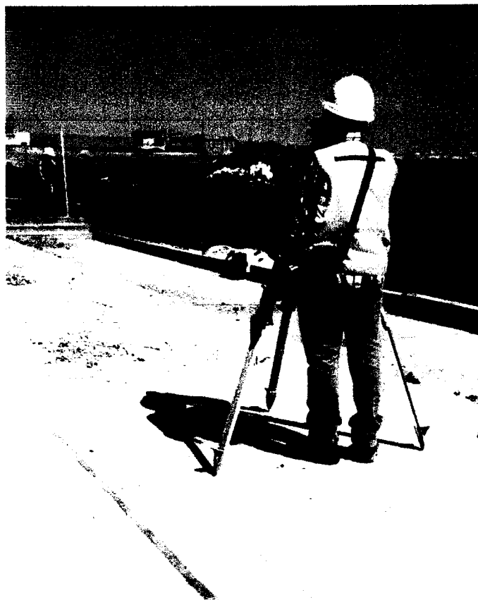
IMAGEN 11 Nivelación de terreno
