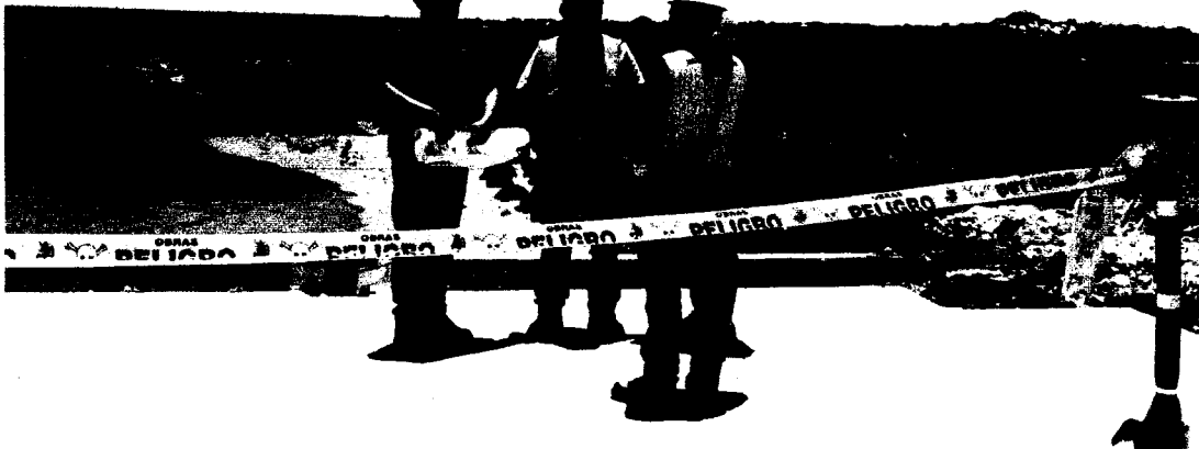
IMAGEN 09 Señalización de Prevención en el área a trabajar
