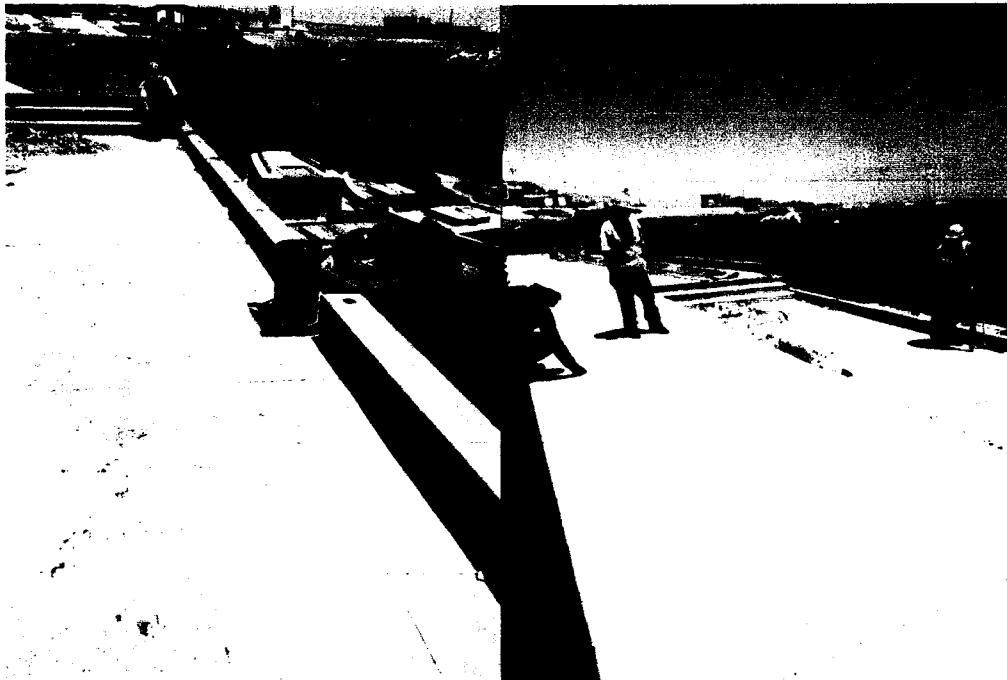
IMAGEN 10 Trazo, Nivel y Replanteo inicial en obra
