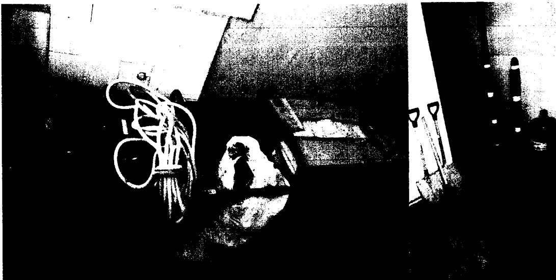
IMAGEN 06 Obras Provisionales – Almacén
