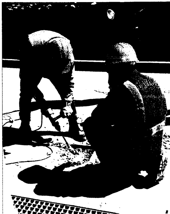
IMAGEN 16 Rotura de losa de concreto
